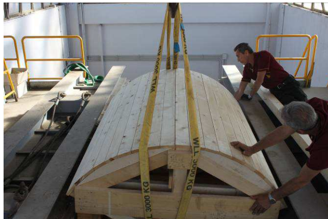
12/5/2015 – figura 25 Calo della centina nella bocca del forno orizzontale
