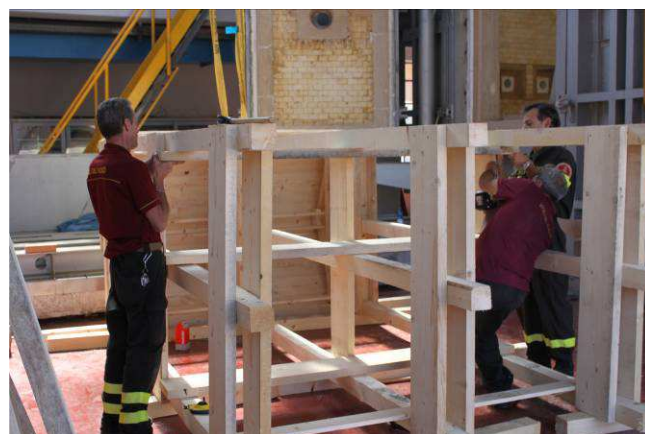
11/5/2015 – figura 19 Fasi di realizzazione piedritti centina
