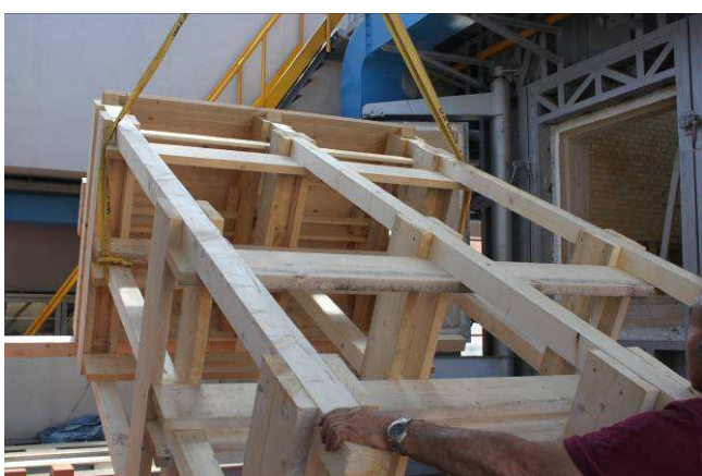
12/5/2015 – figura 22 Issaggio della centina
