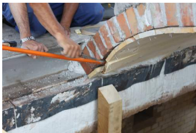
10/6/2015 – figura 49 Rimozione del tavolato
