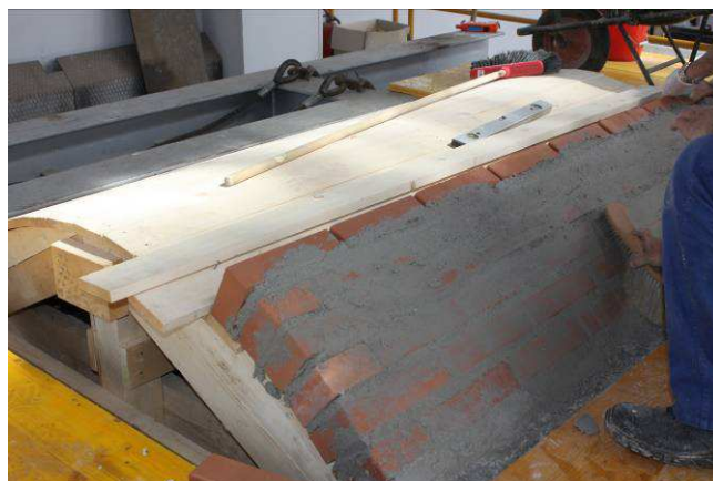
14/5/2015 – figura 29 Prosecuzione della realizzazione della volta muraria
