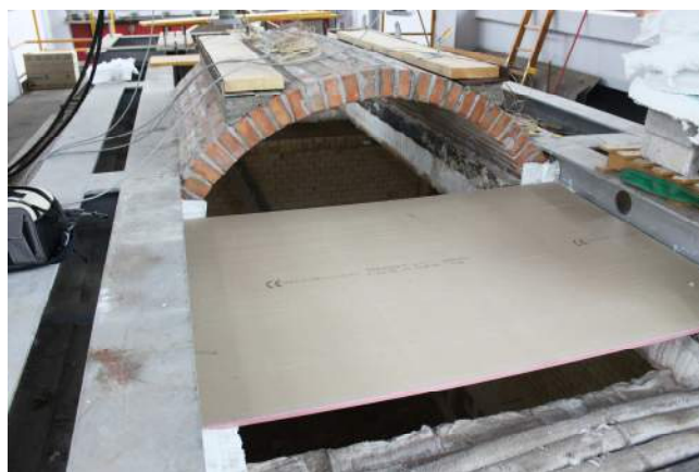
15/6/2015 – figura 53 Inizio tamponatura del forno
