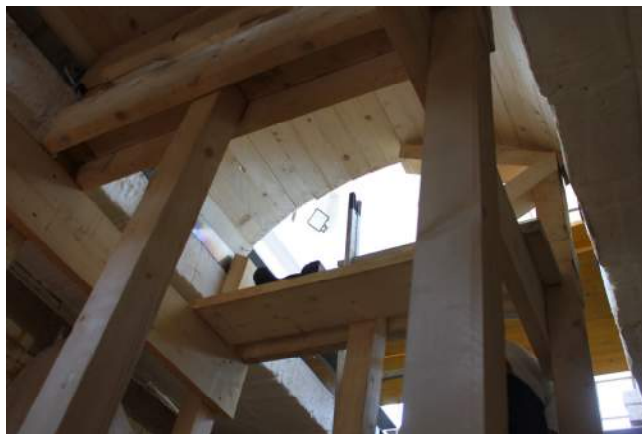
10/6/2015 – figura 47 Inizio rimozione della centina
