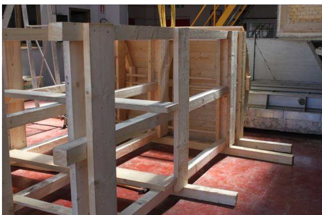
11/5/2015 – figura 20 Completamento realizzazione piedritti centina
