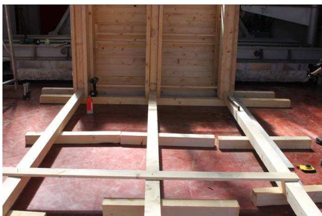
11/5/2015 – figura 18 Inizio realizzazione piedritti centina
